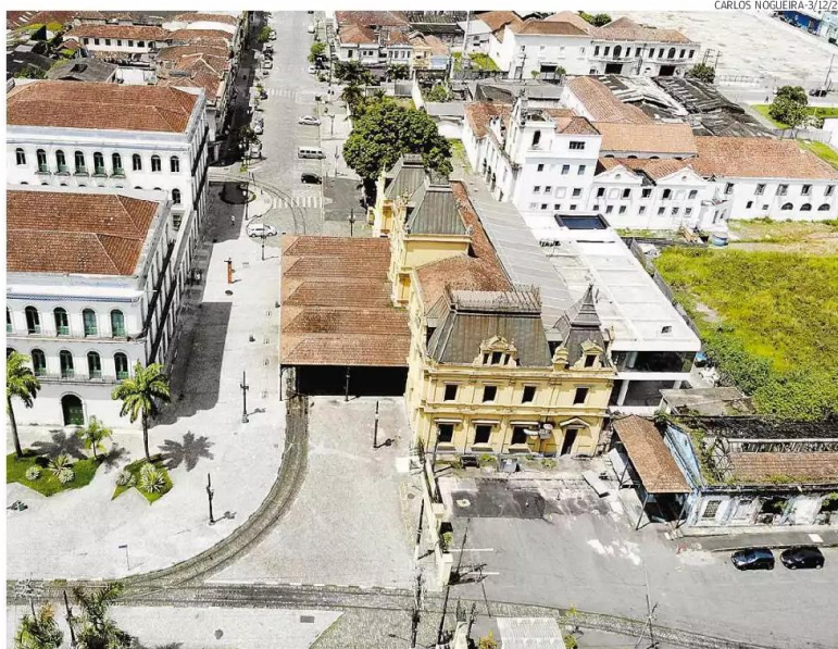
No Valongo, área deve abrigar edifício-garagem, como parte da estrutura para o novo terminal de cruzeiros
