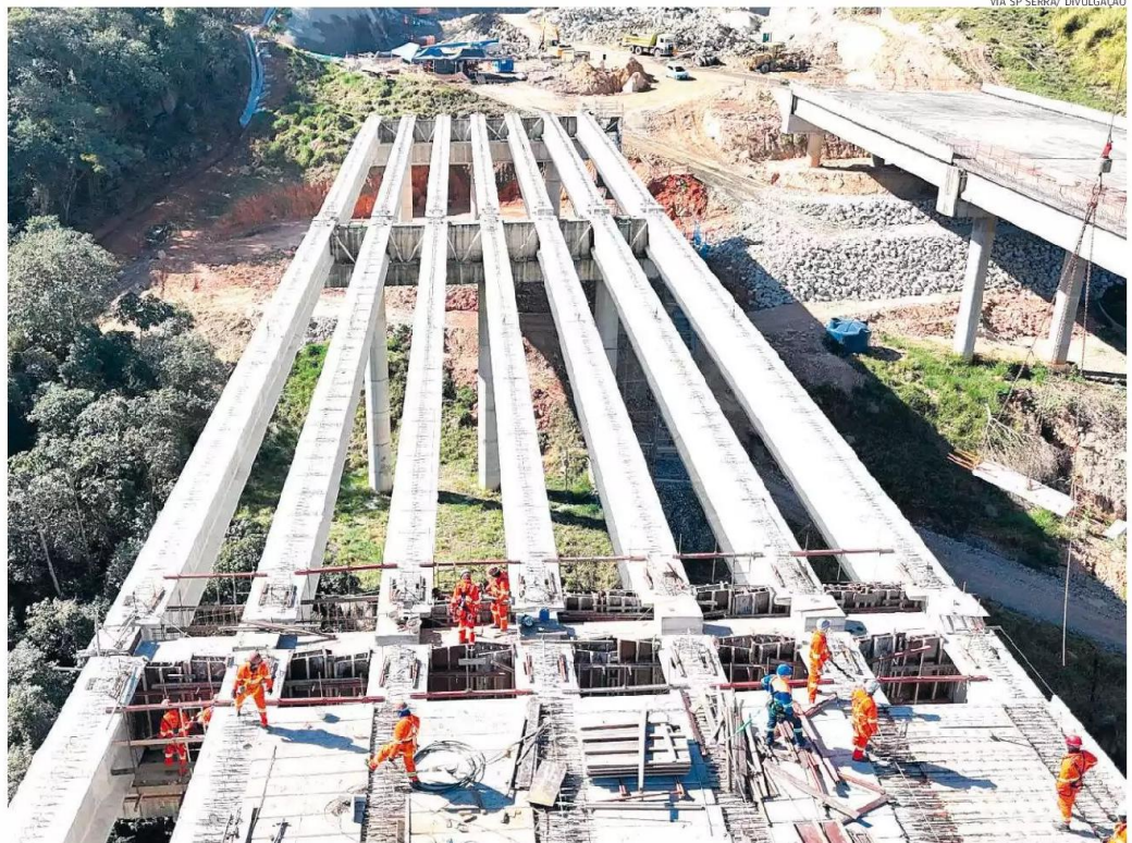
Os 20 quilômetros restantes do Trecho Norte atravessarão os municípios de São Paulo, Guarulhos e Arujá, recebendo alto fluxo de caminhões
