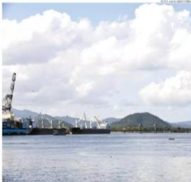
Intervenções ocorrerão entre julho e outubro em três pontos do canal de navegação do cais santista
