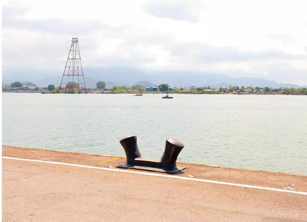
Túnel imerso Santos-Guarujá vai unir as duas margens do Porto de Santos, em uma obra discutida há quase 100 anos na Baixada Santista
