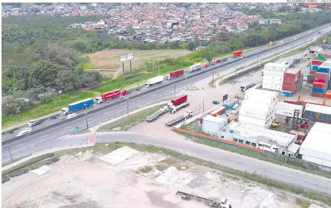
Um dos objetivos da Prefeitura de Guarujá é facilitar o tráfego de veículos, a partir do túnel, em direção à Rodovia Cônego Domênico Rangoni
