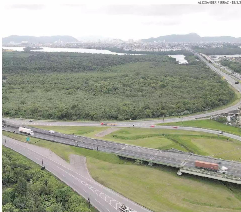
Terreno de 412,5 mil metros quadrados fica na Ilha do Tatu, dentro da poligonal do Porto de Santos
