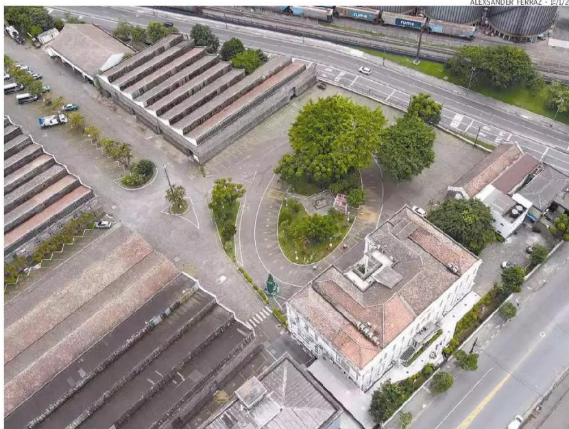
Gestora do Porto reformará um dos galpões existentes em sua sede para receber departamentos
