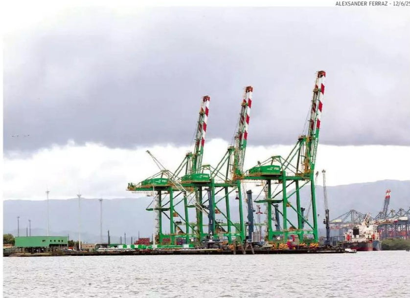
Tecon Santos 10 ficará no cais do Saboó e deve ampliar significativamente a capacidade do Porto
