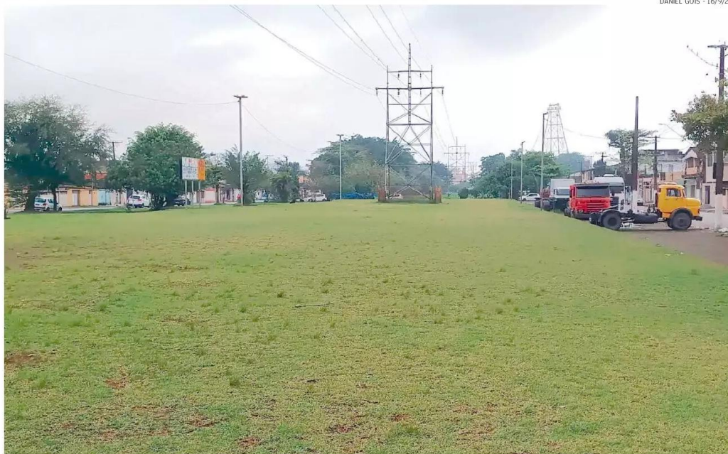
Área conhecida como Linhão, em Vicente de Carvalho, será usada como canteiro para a construção da parte de desembocadura em Guarujá
