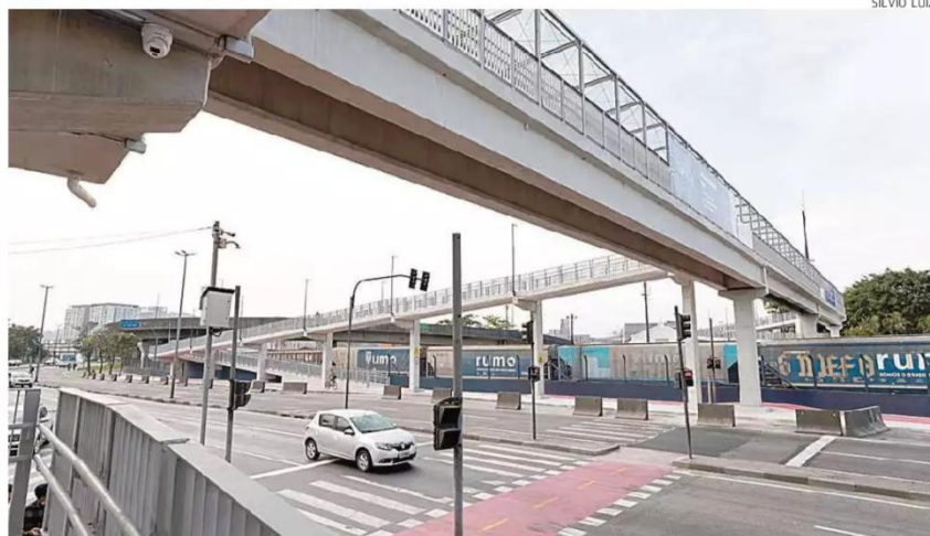
Passagem tem 426 metros de extensão, sendo 80 metros de vão central e 115 metros em cada rampa
