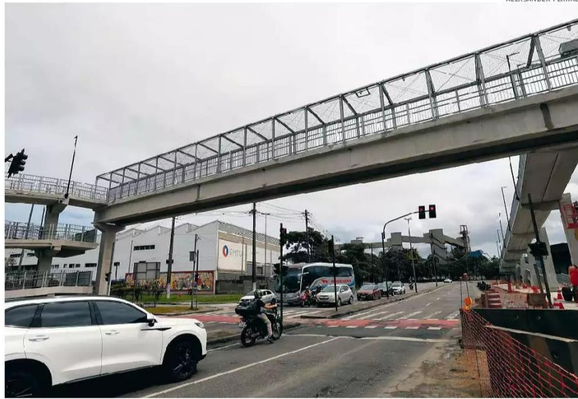
Após a inauguração da passarela de pedestres, semáforo será retirado e a faixa de pedestres, apagada
