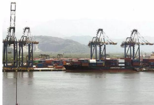
Obras ampliarão capacidade de movimentar grãos e fertilizantes
