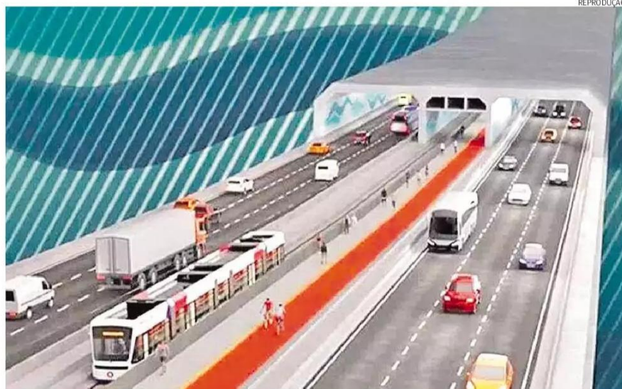
Túnel imerso terá três faixas por sentido, outra exclusiva para o VLT e galeria para pedestres e ciclistas
