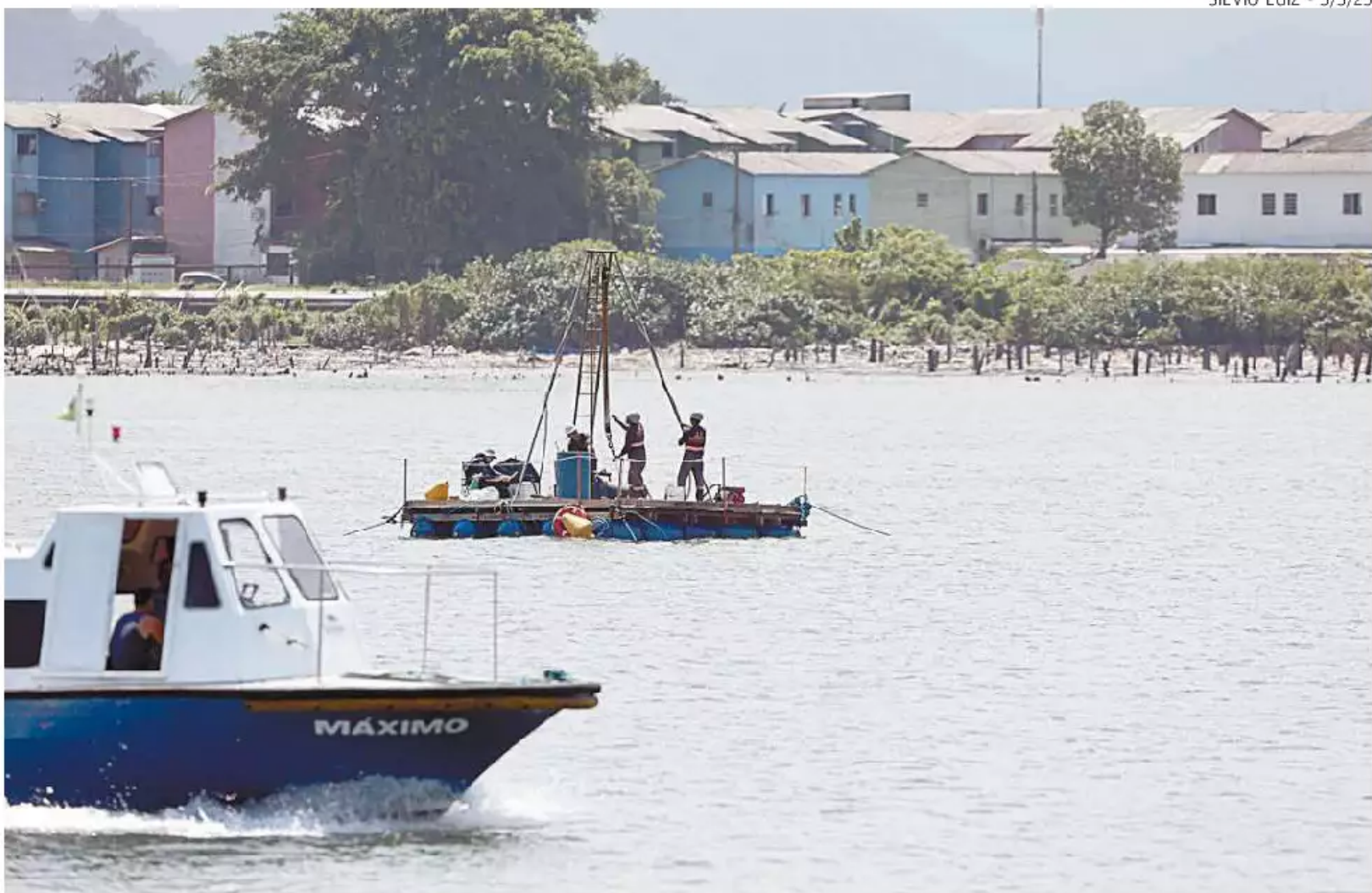
Trabalho de sondagem no trecho do túnel: obra resultará em investimento de R$ 6,8 bilhões do vencedor
