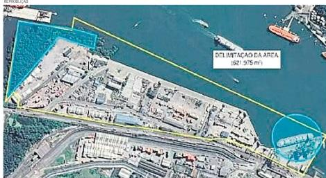
São 621,9 mil metros quadrados que serão arrendados na Margem Direita do complexo portuário santista
