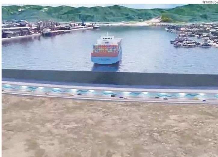
Ligação será composta por seis módulos de concreto, de três células, com largura total de 41 metros
