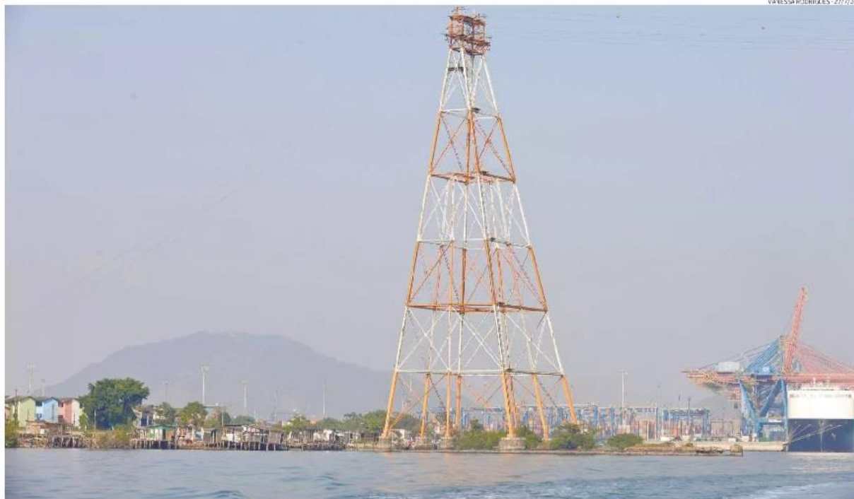
Túnel submerso vai da região do Macuco, em Santos, até Vicente de Carvalho (foto), em Guarujá; projeto prevê 124 desapropriações de imóveis e está na Cetesb para aprovação
