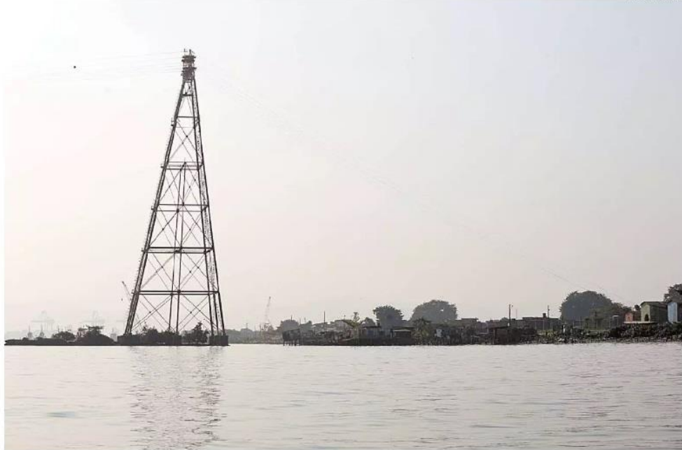
Ligação prevê obras de infraestrutura de acesso nos bairros de Outeirinhos e Macuco, em Santos, e em Vicente de Carvalho, em Guarujá
