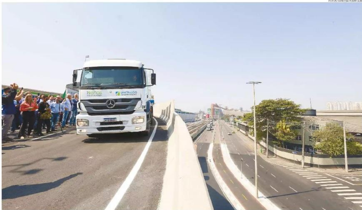
Viaduto de transposição da ferrovia que liga o complexo de celulose da Margem Direita do Porto de Santos à Avenida Governador Mário Covas Jr tem 350 metros de extensão
