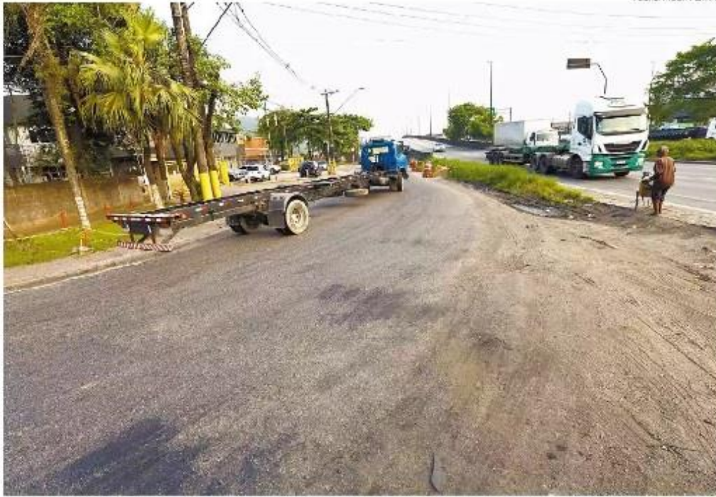
Rua Augusto Scaraboto será pavimentada; prazo de execução é de 12 meses, ao custo de R$ 13,9 milhões
