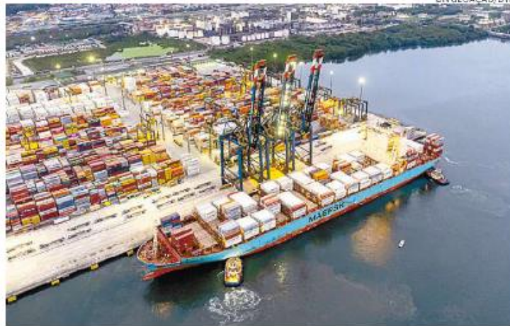
Obras de reparo do berço de atracação foram divididas em três fases
