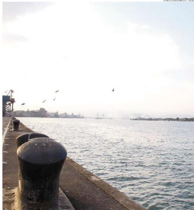
No canal de navegação do Porto de Santos, túnel terá 870 metros de comprimento entre as duas pontas
