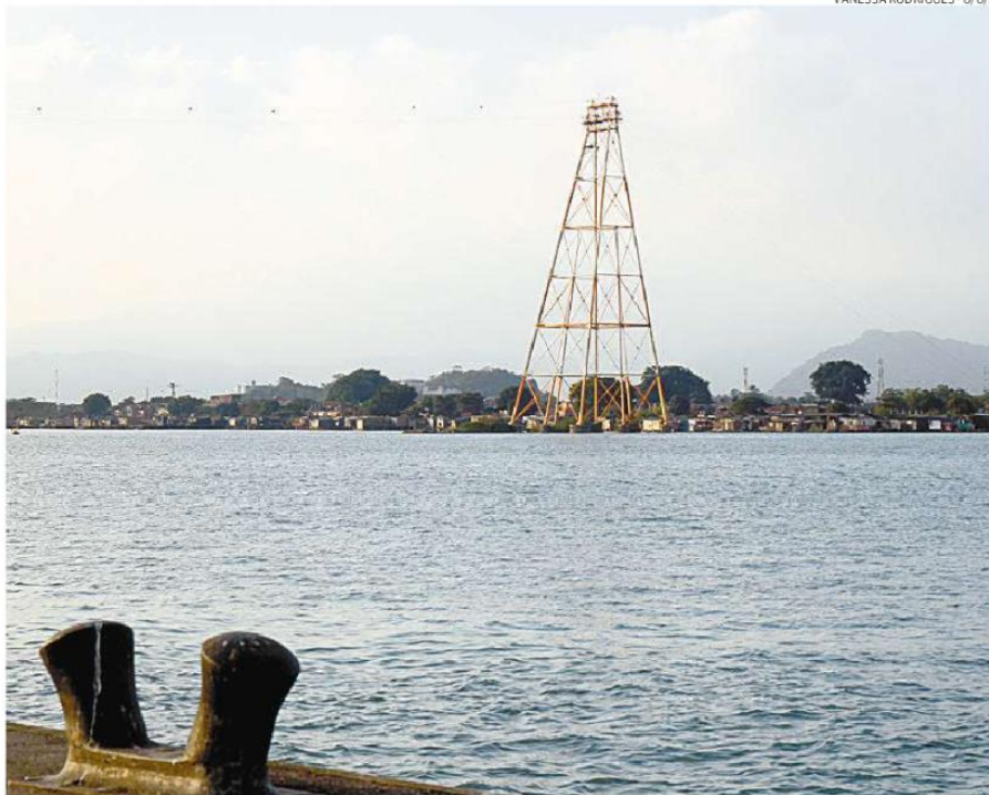
Túnel submerso que será construído entre Santos e Guarujá é a principal obra do PAC na Baixada Santista
