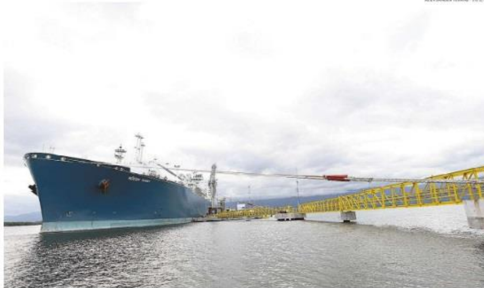
Unidade flutuante de armazenamento e regaseificação, navio-tanque Høegh Giant chegou em fevereiro e atracou no terminal da empresa
