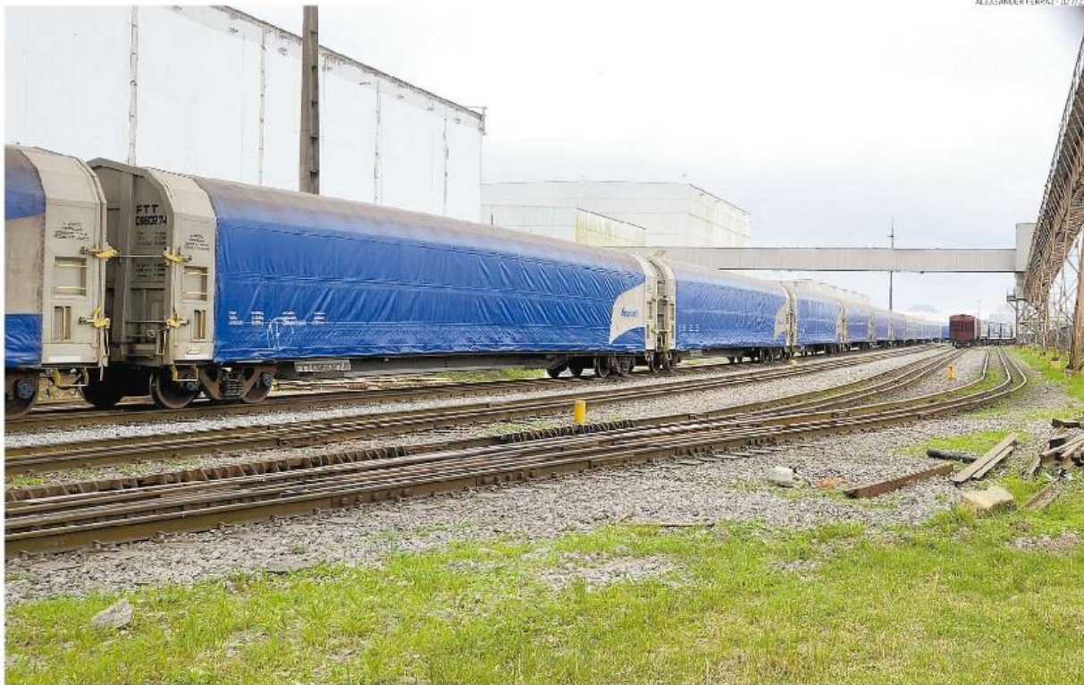
A agência reguladora informou que foram realizadas fiscalizações, em conjunto com a Agência Nacional de Transportes Terrestres, na Ferrovia Interna do Porto de Santos, a Fips
