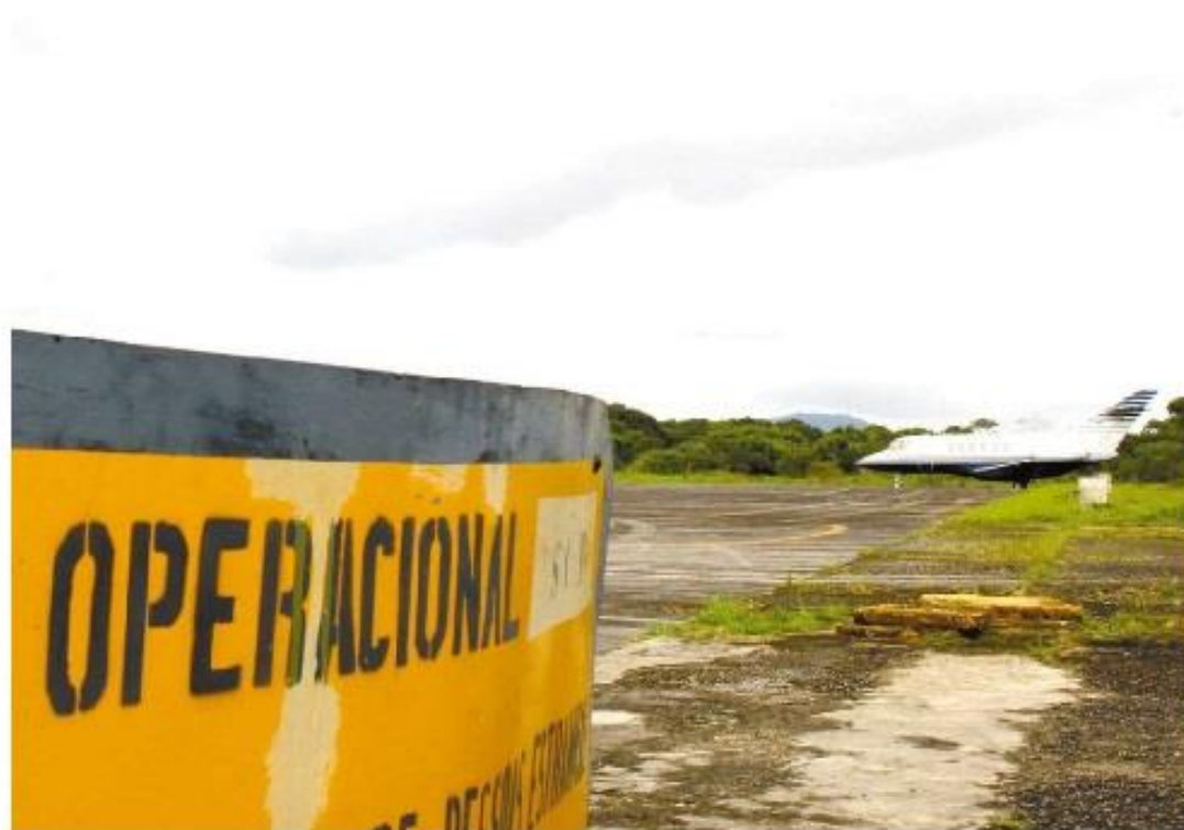
Terracom Construções venceu licitação para etapa inicial dos serviços, que custará R$ 19,029 milhões
