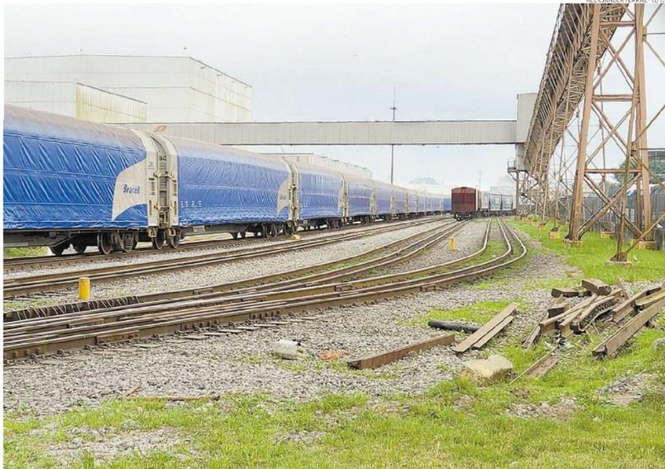
Projeto prevê 13 obras estruturantes, decisivas para ampliar a movimentação de carga das atuais 51 milhões de toneladas para 115 milhões
