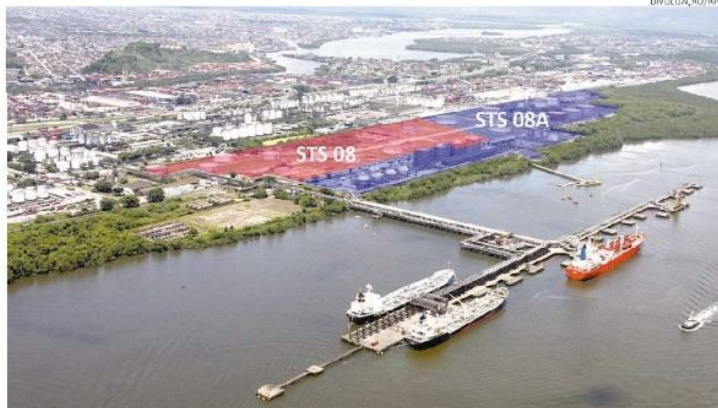
Área denominada ST508, que ainda não foi arrendada, também está dentro do escopo a ser pesquisado
