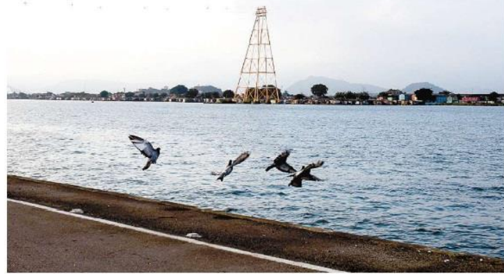
Traçado do túnel tem 860 metros de extensão, do cais da Marinha, em Santos, até Vicente de Carvalho
