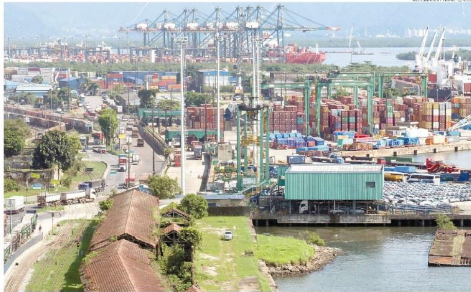
Com mais de 600 metros quadrados no Saboó, a STS10 armazenaria contêineres, mas pode receber ainda um novo terminal de cruzeiros
