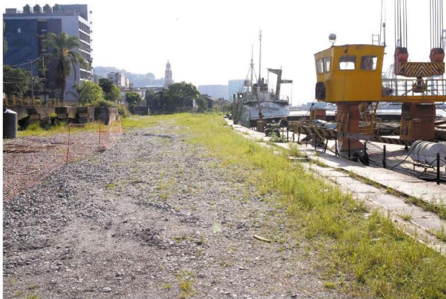
Caberá à unidade, que terá no comando o secretário adjunto de Infraestrutura e Edificações, Luiz Felipe Tonelli Távora, acompanhar as obras
