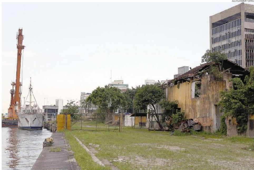
Área onde será instalado o Parque Valongo: ministro de Portos e Aeroportos acompanha início das obras na tarde de hoje no porto santista
