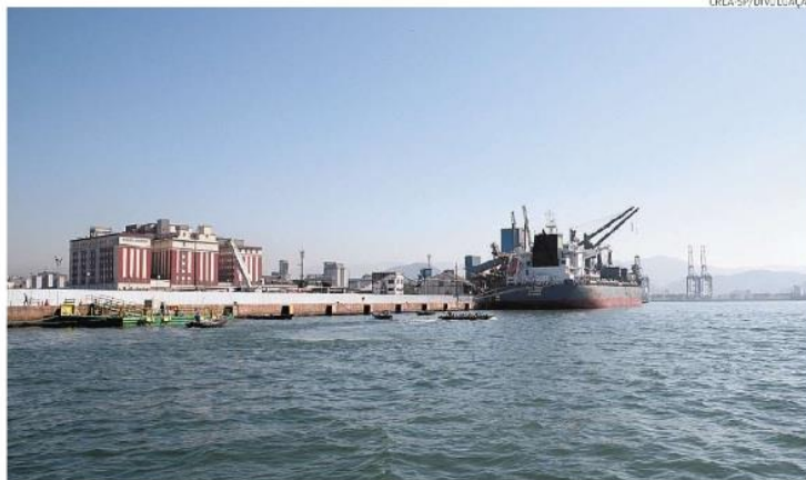
Equipe técnica do Crea-SP esteve no canal do Porto de Santos e viu por onde deve passar túnel submerso
