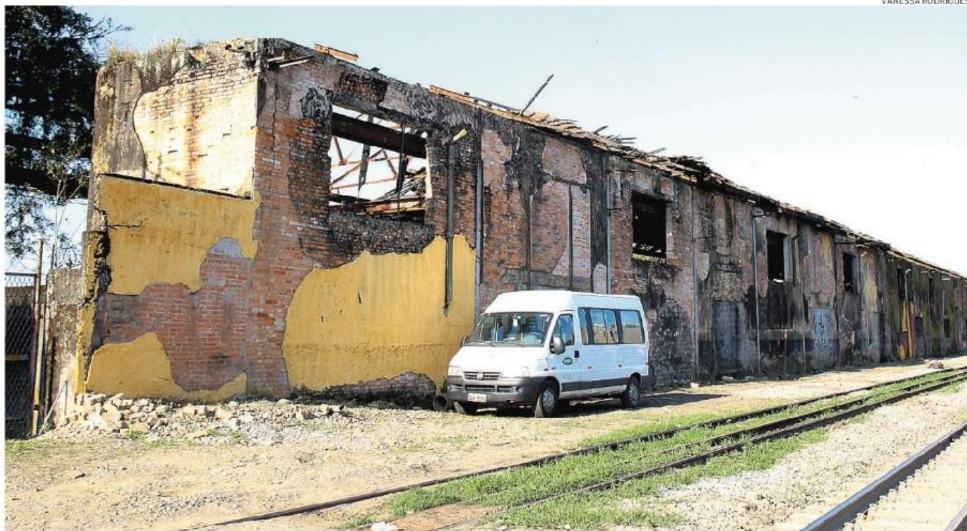
Recuperação dos armazéns 1, 2 e 3 é aguardada há décadas pelo setor portuário e deve sair do papel com execução do projeto Parque Valongo
