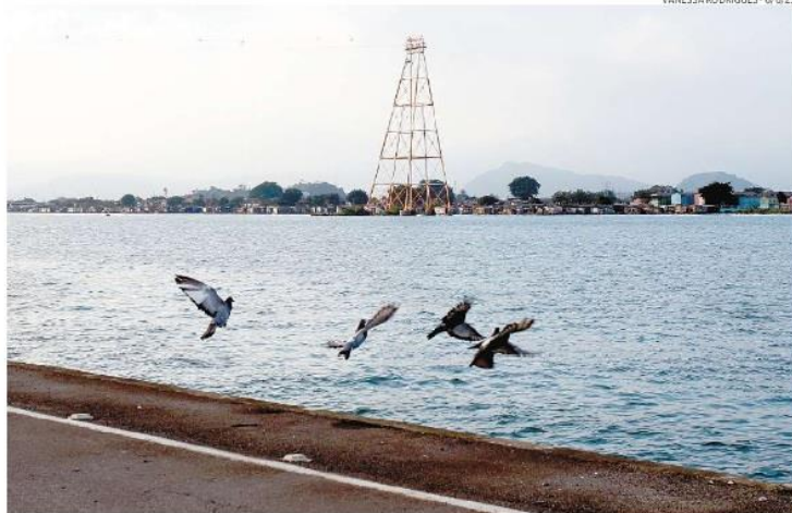
As embocaduras do túnel estão previstas para o Cais da Marinha, em Santos, e na Prainha, em Guarujá
