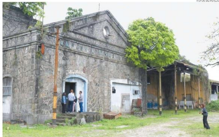
Mapeamento dos armazéns 4, 5 e 6 e das Casas de Pedra foram finalizados pela Prefeitura de Santos
