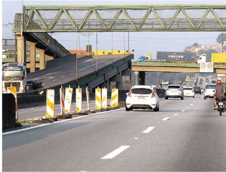
Existência de apenas um viaduto para entrar e sair do Distrito Industrial da Alemoa preocupa empresários
