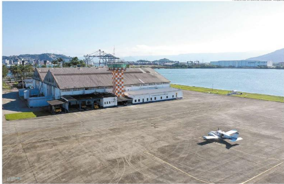
Prefeitura de Guarujá licitará parte dos serviços da primeira fase do Aeroporto Civil Metropolitano, na Base Aérea, em Vicente de Carvalho
