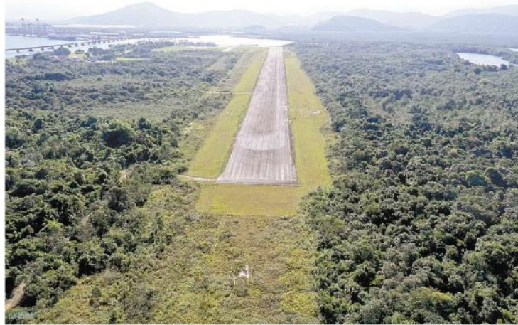
Reforço, regularização das faixas, drenagem e cercamento da pista estão entre os serviços programados
