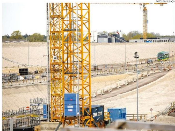
As obras do túnel que ligará Copanhegue a Hamburgo tiveram início em 2020 e devem seguir até 2029
