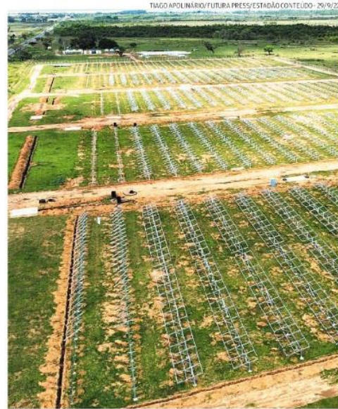
Painéis em instalação em Bataguassu (MS): fonte solar supera Itaipu
