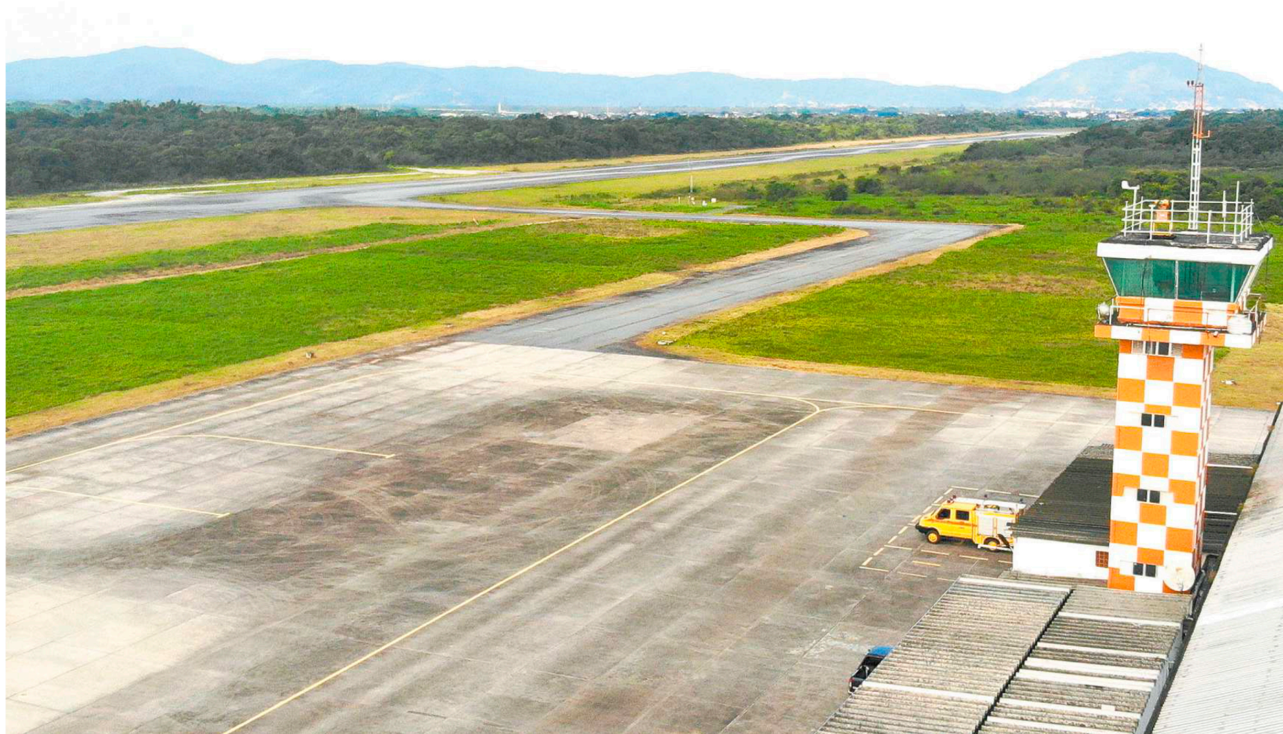
A pista do aeroporto, na Base Aérea de Santos, tem 1.390 metros de extensão e 150 metros de largura (com áreas laterais de segurança, chegando a 1.500 metros no total)
