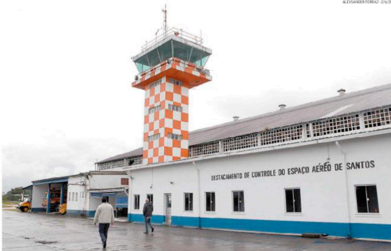
As intervenções necessárias para permitir decolagem e pouso de aeronaves já têm dinheiro reservado. Porém, o início delas ainda é incerto
