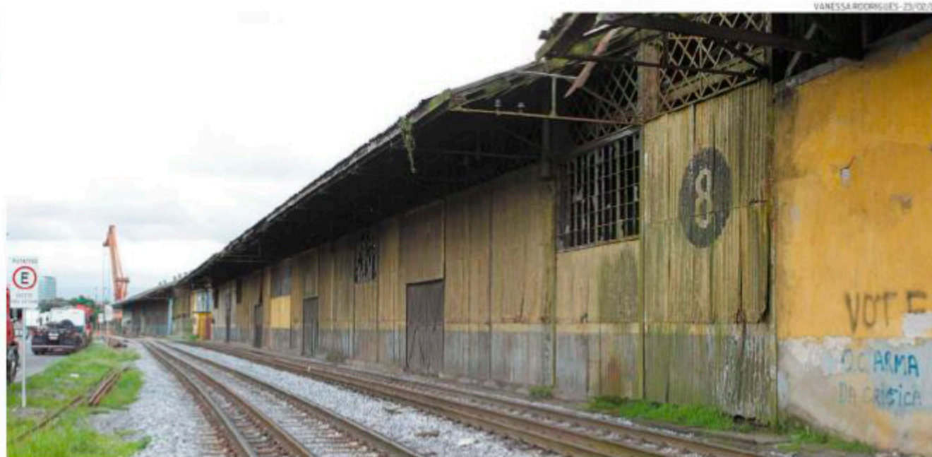
Ideia da SPA é transferir atividades de cruzeiros para a região entre os armazéns 1 ao 8, do Valongo, que estão deteriorados há muitos anos
