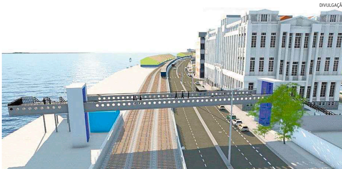
O projeto - elaborado a partir de uma parceria entre a Prefeitura de Santos, a Autoridade Portuária e a Portofer - prevê uma passarela com elevadores nas extremidades, atendendo o terminal da travessia de barcas no Centro de Santos.
