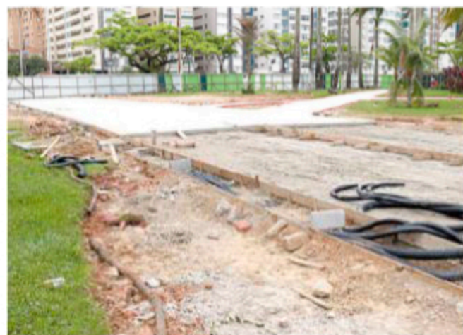
Já se está remodelando a parte do jardim mais próxima à ciclovia...
