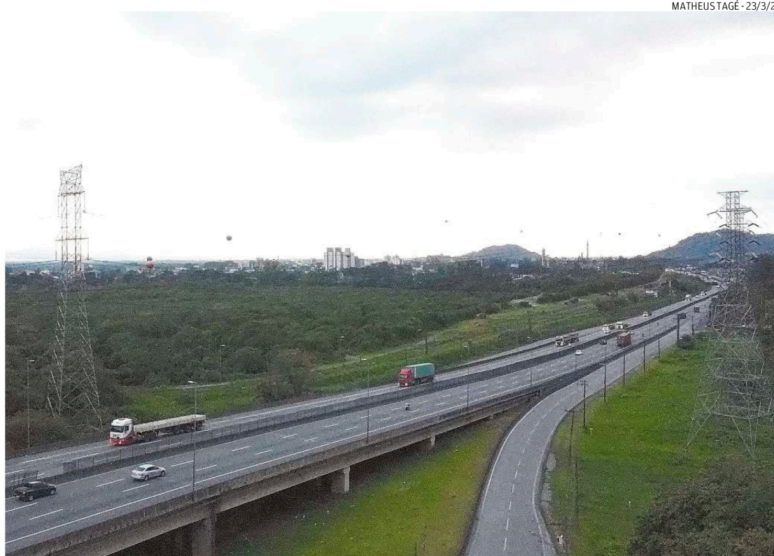
Plano é conectar o Rodoanel à Margem Esquerda do Porto e à Rodovia Cônego Domênico Rangoni (foto)
