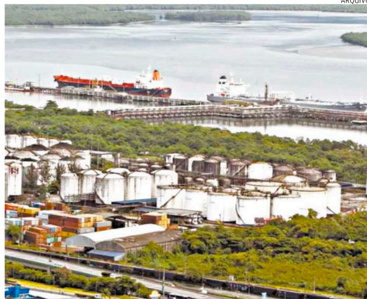
Pier da Alemoa, em Santos, vai ganhar dois berços de atracação
