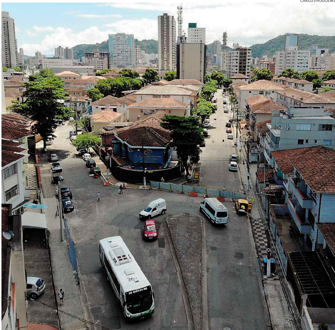
Serviços transcorrem na Av. Rodrigues Alves, entre a Av. Washington Luís e a Rua São Vicente de Paula
