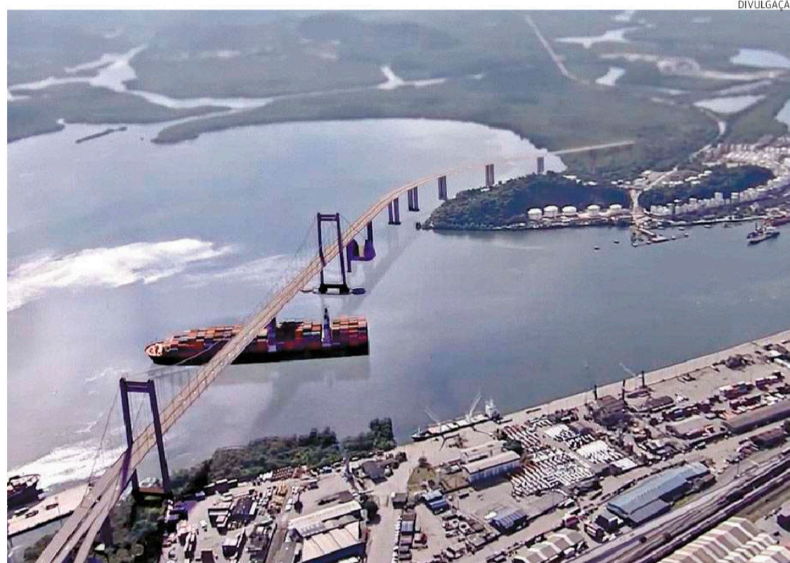
Ponte foi projetada para cruzar o canal de navegação entre a região da Alemoa e a Ilha Barnabé
