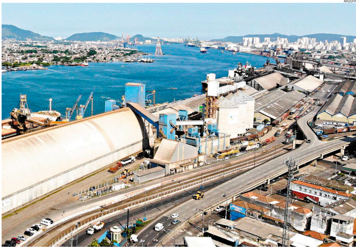
Canal de navegação do Porto de Santos: chefe da unidade paulista da Antaq defende crescimento do complexo marítimo em direção ao mar
