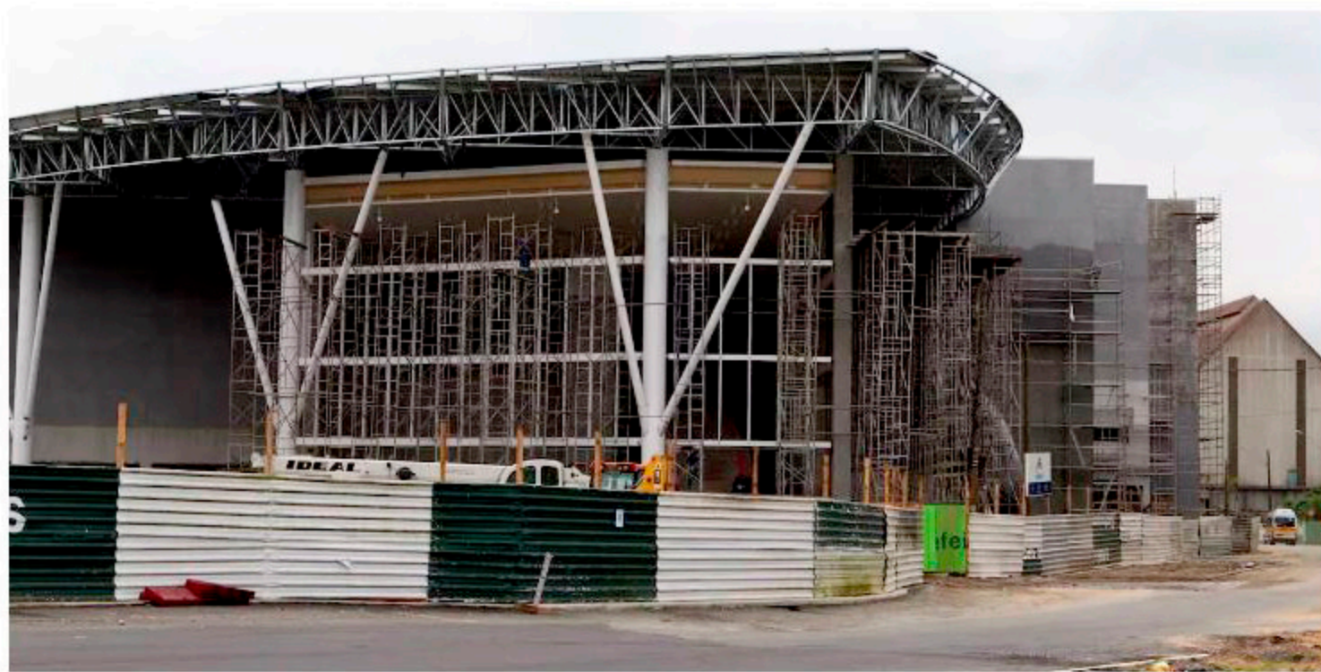
Construção do Centro de Atividades Turísticas está 95% concluída, diz Município (Alexander Ferraz/AT)
